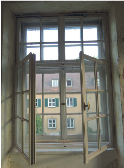
Bild 117: Kastenfenster mit Sprossen unterteilt in einem denkmalgeschützten Gebäude (Quelle: Christine Uske)
