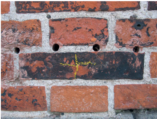
Bild 38: Anordnung der Bohrungen für die Cremetechnologie (Quelle: Franz-Josef Hölzen)
