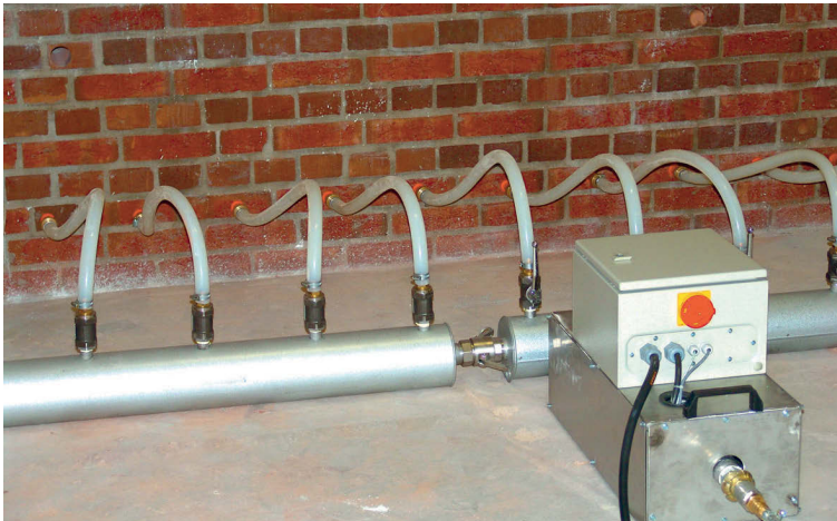
Bild 40: Inbetriebnahme der Anlage (Quelle: Franz-Josef Hölzen)
