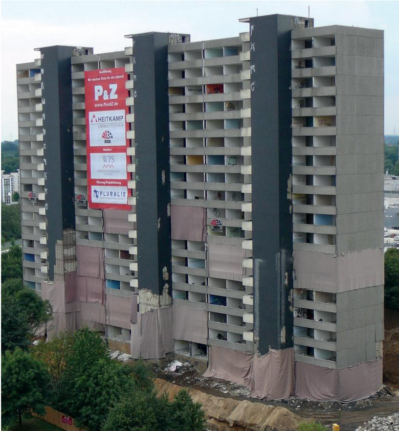
Abb. 4.3.4-2 Mit Vlies abgehängte Sprengeneben (Hochhaus Marl) (Quelle: W. Werner)
