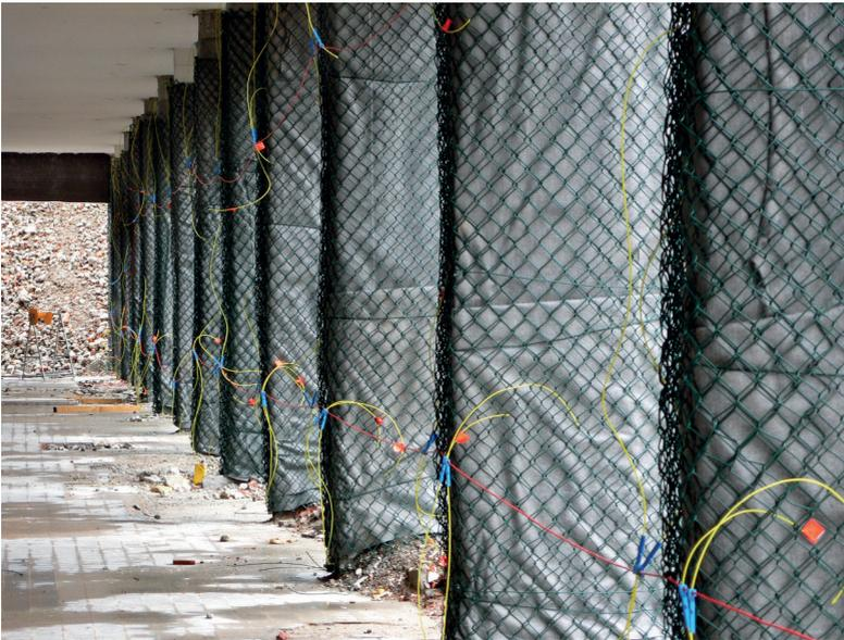
Abb. 4.3.4-1 Mit Geotextil und Maschendraht ummantelte Pfeiler (Krankenhaus Vöcklabruck)
